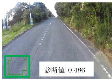
図-4 ひび割れ画像写真の表示
